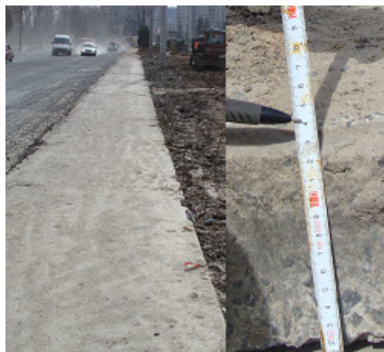
Рис. 1. Загальний вигляд досліджуваної ділянки автомобільної дороги
